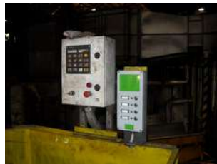
Sistema selettivo in un laminatoio Selective intercoms in rolling mill plant
