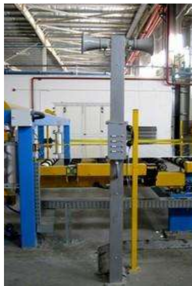
Sistema ad anello in una vetreria Ring intercom in glass factory
